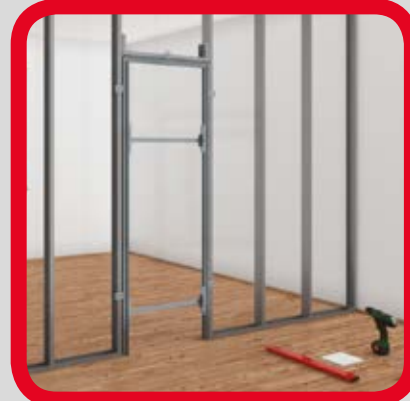
Zárubeň vložte do stavebního otvoru
