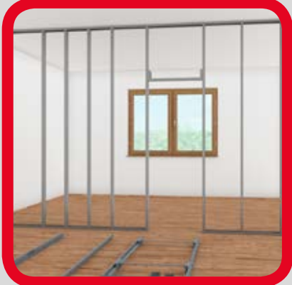
Připravená konstrukce SDK pro usazení zárubně
