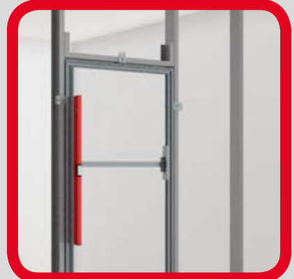
Vyvažte zárubeň vertikálně
