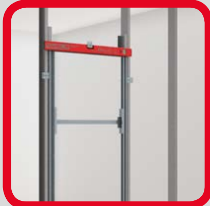
Vyvažte zárubeň horizontálně
