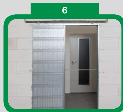
Zapěněné pouzdro ve stavebním otvoru
