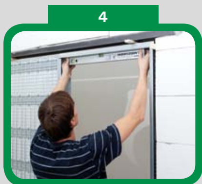
Vyvažte stavební pouzdro horizontálně a vertikálně
