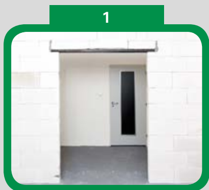
Připravený stavební otvor
