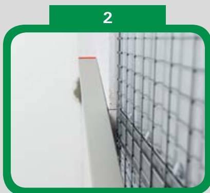
Vložte stavební pouzdro do stavebního otvoru
